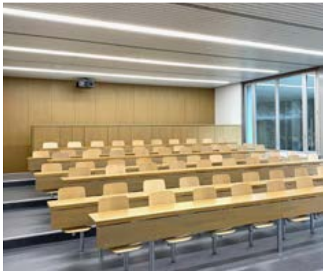
Aule universitarie dell'ETH, Zurigo Sostituzione del vecchio impianto di illuminazione con una soluzione personalizzata con lampade a incasso e bocchette di aerazione per il collegamento delle condutture dell'aria di alimentazione e di scarico.
