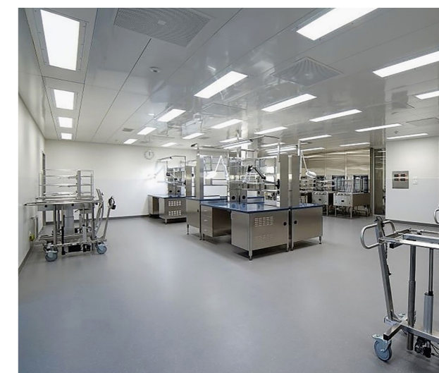
Hôpital de Muri (AG) Rénovation à l'aide d'un luminaire conçu pour les salles blanches et doté d'obturateurs à plusieurs niveaux.
