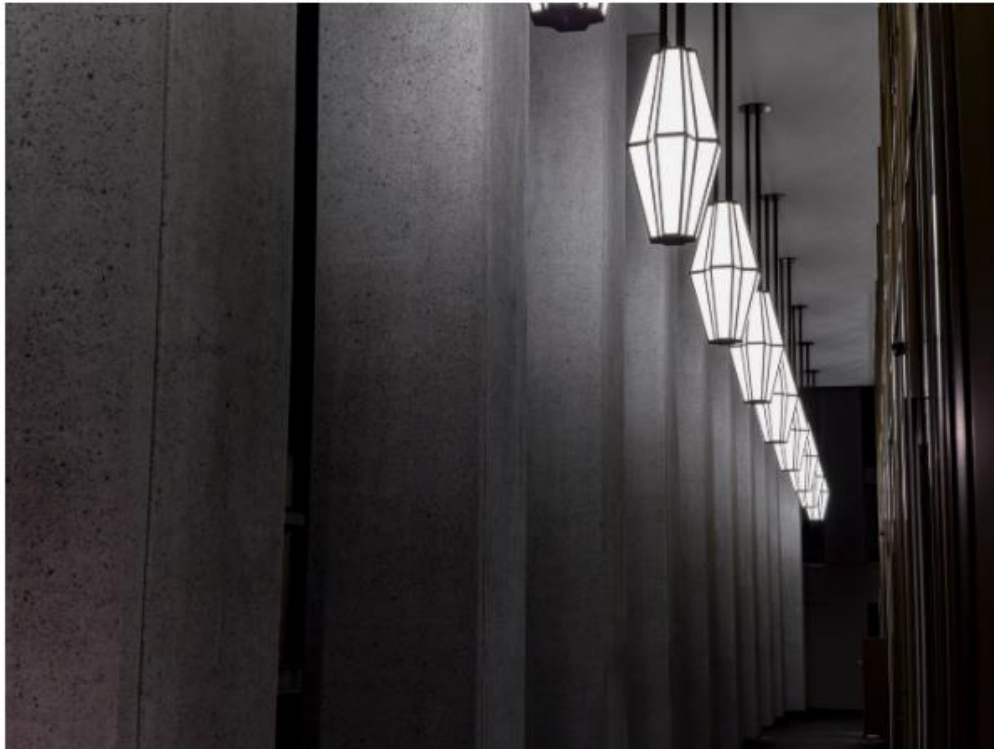
Die einzelne Leuchte setzt sich aus zwei polygonalen, becherförmigen Elementen zusammen, die – aufeinandergestellt – in der Mitte zusammenschraubt wurden.
